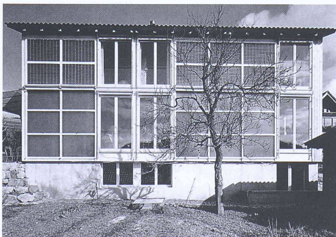
40 m 2 transparente Wärmedämmung (TWD) im Pfosten/Riegel-System sind das Kernstück dieses Niedrigenergiehauses in Ormalingen BL. Zusammen mit den Fenstern ergibt sich eine komplette, einwandfrei gestaltete Fassade, die mit dem Anerkennungspreis
