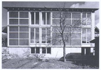
40 m² transparente Wärmedämmung (TWD) im Pfosten/Riegelsystem sind das Kernstück dieses Niedrigenergiehauses in Ormalingen BL. Zusammen mit den Fenstern ergibt sich eine komplette, einwandfrei gestaltete Fassade, die mit dem Anerkennungspreis «bestintegrierte Solaranlage» ausgezeichnet wurde. Im Rahmen eines Bundesprojektes werden hier ausführliche Begleitmessungen durchgeführt. Zwischenresultate zeigen, dass die Energiebilanz der TWD-Fassade immer positiv ist
