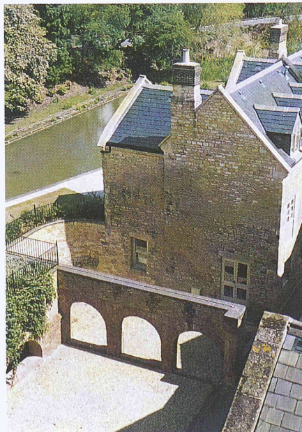
Blick vom Treppenturm auf das ehemalige Wohnhaus
