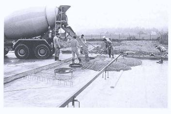
Bild 4. Einbringen des Betons aus dem Fahrmischer
