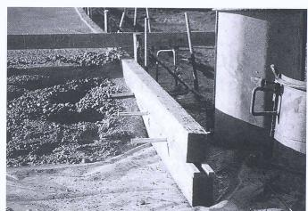
Bild 3. Etappenabschalung mit verzinkten Stahldornen
