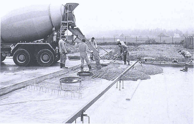
Bild 4. Einbringen des Betons aus dem Fahrmischer
