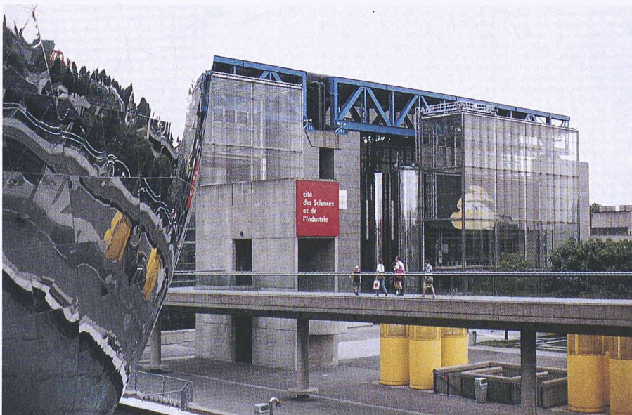
Bild 4. Gewächshäuser der Cité des sciences et de l'industrie von Aadrin Fainsilber und Peter Rice, Paris 1990. Hängende, mit vorgespannten Seilträgern senkrecht zur Glasebene gehaltene Tafelfelder aus sekurisiertem Floatglas
