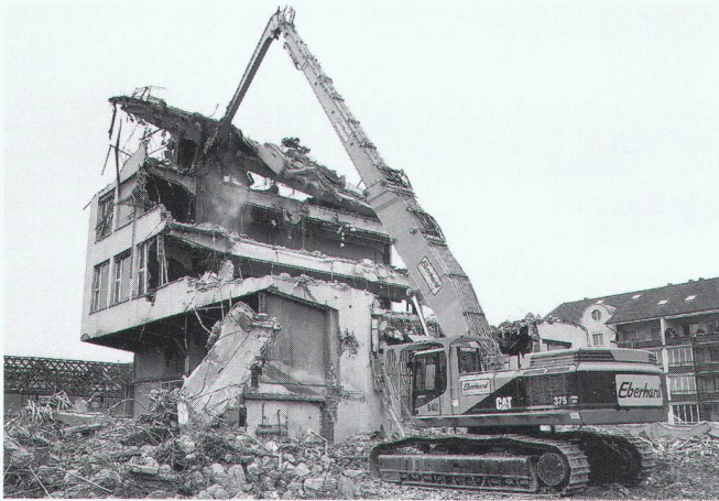
Unser neustes Kraftpaket: der 85-Töner CAT 375. Mit der Langausrüstung erreicht er eine Arbeitshöhe von bis zu 32 Metern(!) und setzt damit neue Massstäbe im rationellen Rückbau.
