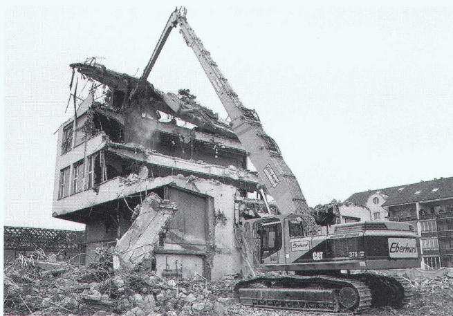
Unser neuestes Kraftpaket: der 85-Tonner CAT 375. Mit der Langausrüstung erreicht er eine Arbeitshöhe von bis zu 32 Metern(!) und setzt damit neue Massstäbe im rationellen Rückbau.
