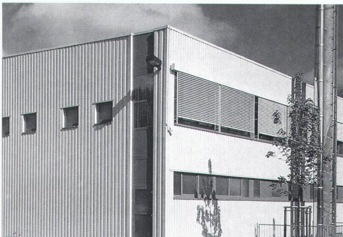
Hoesch Trapezprofile sind in den verschiedensten Anwendungsbereichen als Flächentragwerk und Raumabschluß einsetzbar. Architekten und Planer eröffnen sie durch die unterschiedliche Profilgeometrie eine Vielfalt an Gestaltungsmöglichkeiten.
