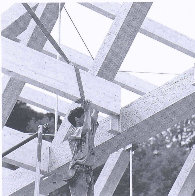
Bild 7. Anschluss einer Brettschichtholzpfette am Untergurt
