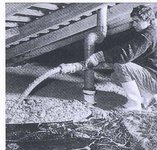
Hauptbahnhof Bern, 260 m<sup>3</sup>, von vier Mann in vier Tagen eingebaut; Telecom, Ostermundigen, 7520 m<sup>3</sup>, Thermozell Mix 7 cm hoch als Ausgleichsschicht anstelle von lose verlegten Styroporplatten).
