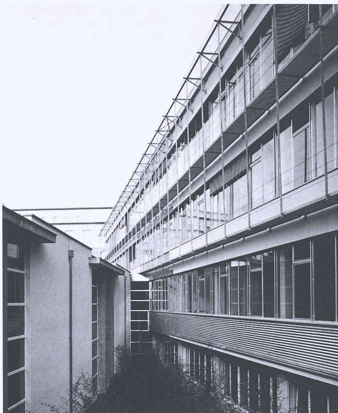
Unitobler: Hörsaal- und Lerchenwegtrakt mit Bambushof
