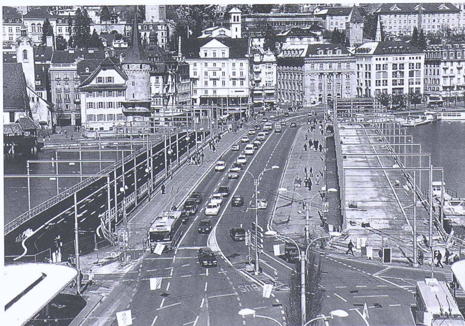
Die alte Luzerner Seebrücke mit den beiden Hilfsbrücken rechts und links, die für rund 18 Monate Bauzeit den Verkehr aufnehmen müssen (Bild: Comet)
