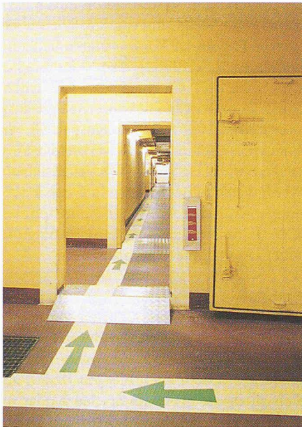
Fluchtwegmarkierung und Äusgänge markiert mit nachleuchtender Farbe (Bild: Longlite Technologies AG)
