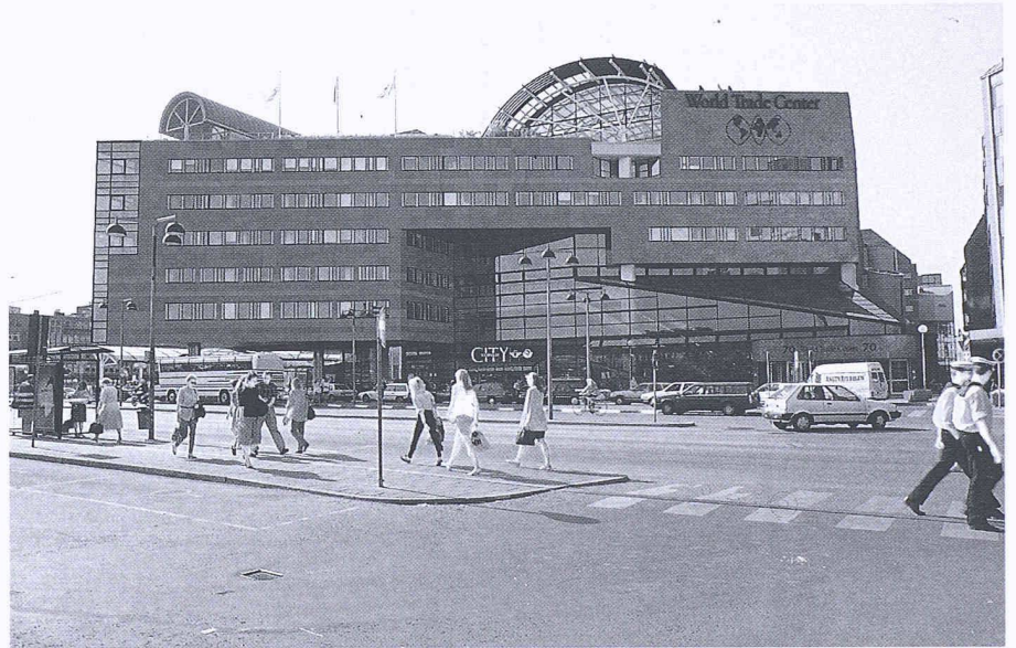
Vasa Terminal mit dem World Trade Center, Südansicht
