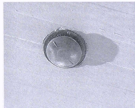
Bild 7. Kugelförmiger Luftauslass in der Küche (Beispiel Riehen)
