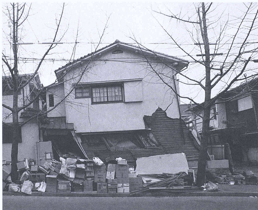
Bild 14. Nach links gekipptes Holzhaus («soft-story»-Effekt)
