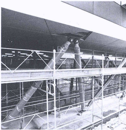
Bild 12. Verstärkung des Physikgebäudes HPH der ETH Hönggerberg
