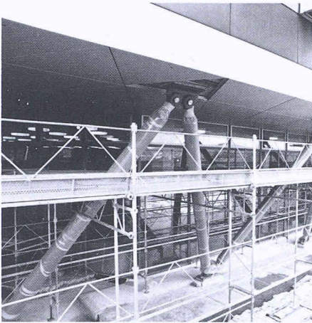
Bild 12. Verstärkung des Physikgebäudes HPH der ETH Hönggerberg
