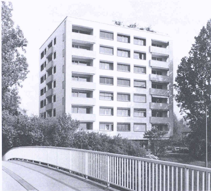
Bild 2. Saniertes Mehrfamilienhaus an der Lättenwiesenstrasse in Glattbrugg (Objekt B)
