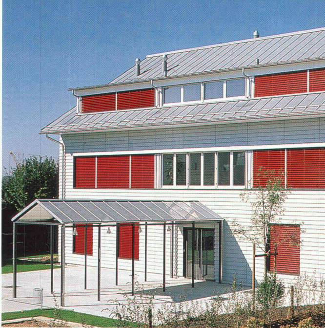
Schulhaus in Lömmenschwil/SG
