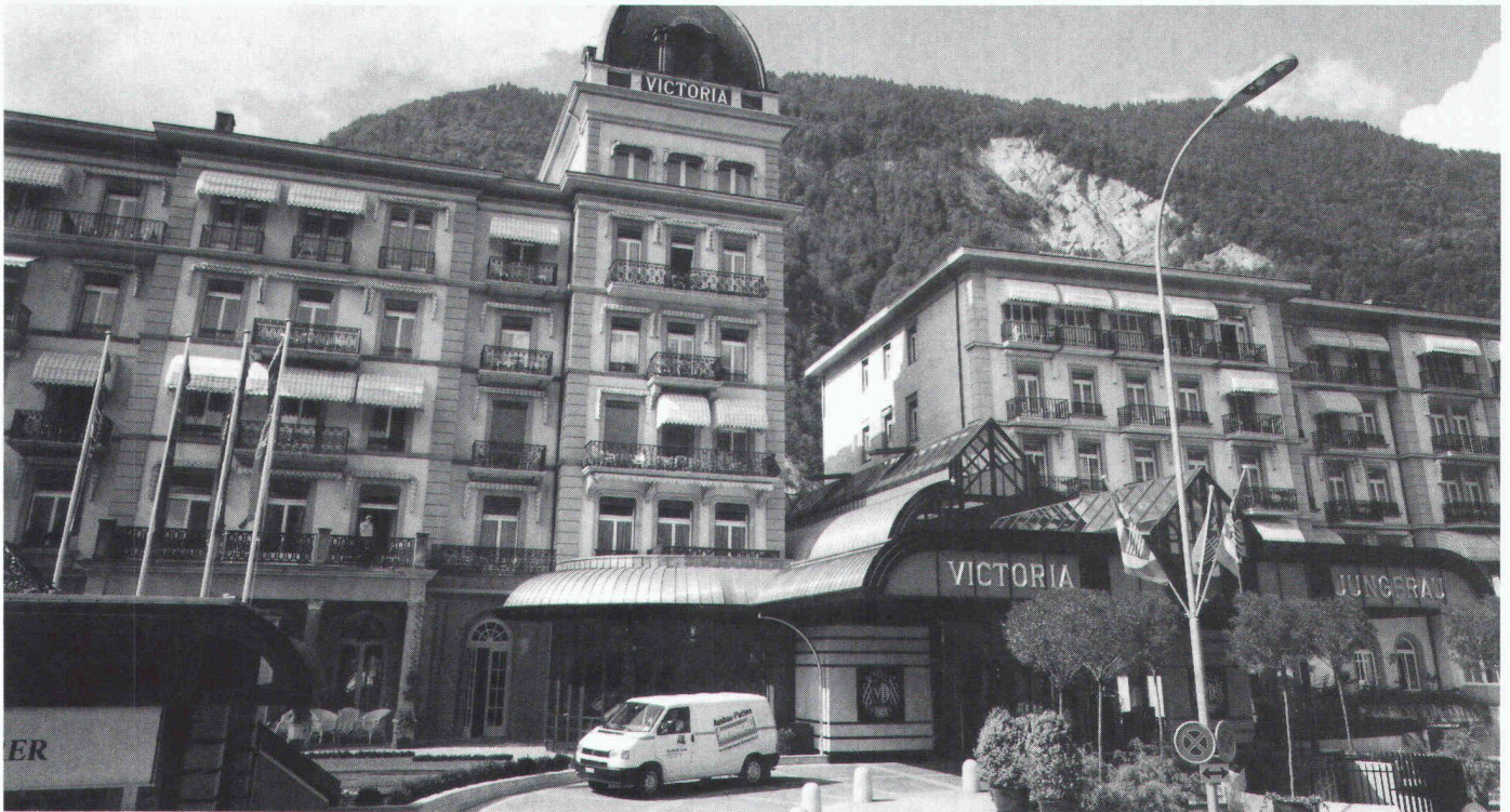
Architekt: Züblin Anlagen + Projekte AG, Zürich Bauausführung: Schaller Trockenbau AG, Belp
