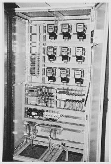
Bild 4. Schaltschrank für Zähler und Sicherungen
