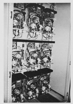
Bild 5. Schaltschrank für Wechselrichter
