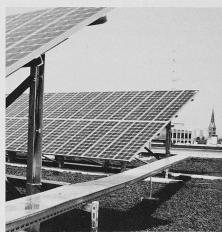
Bild 2. Tragstrukturen für Solarmodule
