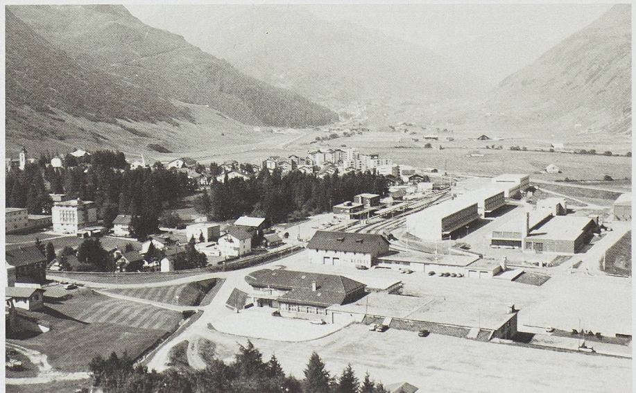
Bild 3. Das Kasernenareal ist sowohl durch die grossvolumigen Bauten als auch durch die fehlende Bepflanzung schlecht ins Ortsbild von Andermatt integriert. Im Hintergrund der offene Landschaftsraum der Reussebene (Urserental)
