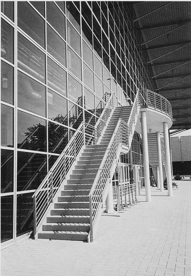
Die Treppenanlage in der Mitte der Hauptfassade
