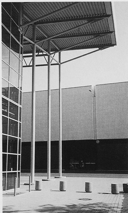
Stützen an der Eckauskragung
