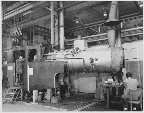
Bild 4. Prüfstand für die Ölfeuerungsversuche mit provisorisch isoliertem BRB-Kessel. Beim Führerstand handelt es sich um ein Modell in Originalgrösse, hergestellt für die österreichischen Gewerkschaften. Bild: SLM
