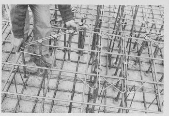
AncoPlus-Durchstanzbewehrungen lassen sich nachträglich, d.h. nach dem Verlegen der Biegebewehrung, von oben in die Bewehrung einschieben. Das ermöglicht dem Ingenieur eine einfache Kontrolle und wenn erforderlich Korrektur der Montagearbeiten
