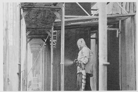
Bild 6. Applikation eines hochleistungsfähigen Spritzmörtels im Trockenspritzverfahren
