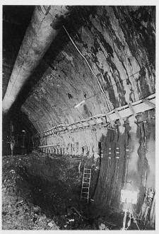
Abbildung 4. Strassenabbau mit Verlängerung der Gewölbebögen
