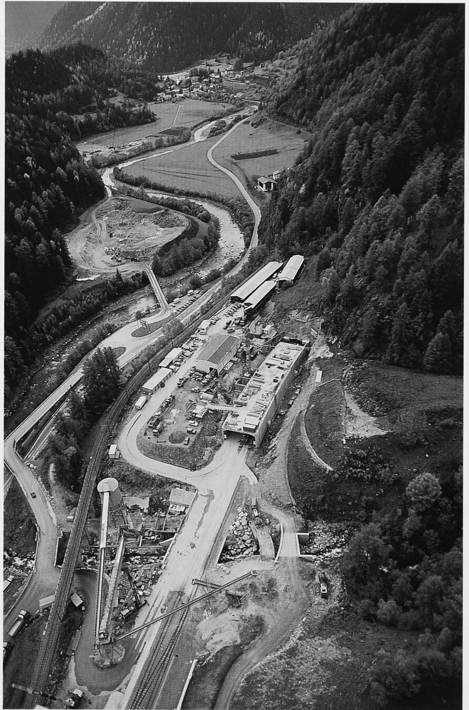
Bild 1. Übersicht über das Installationsgelände und den Portalbereich
