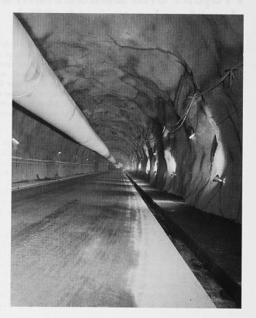
Bild 6. Zweispurtunnel, Rohbau fertig
