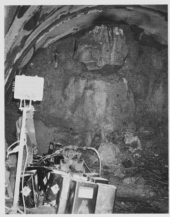
Bild 7. Sicherung eines Felsblockes im Scheitelbereich durch PU-Injektionen
