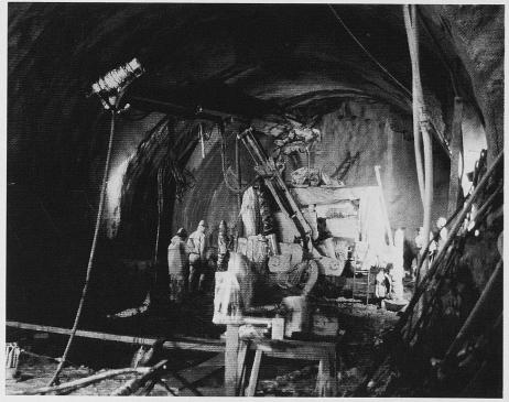
Bild 4. Horizontal-Jetgerät im Einsatz
