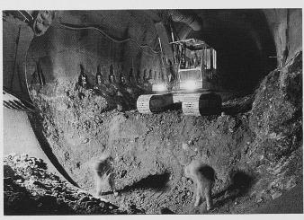
Bild 6. Strossabbau mit Hydraulikbagger
