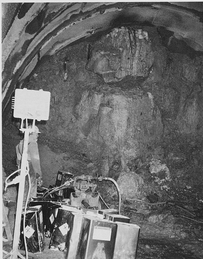
Bild 7. Sicherung eines Felsblockes im Scheitelbereich durch PU-Injektionen
