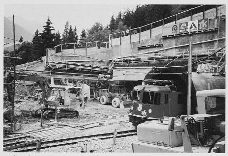
Bild 2. Blick in den Voreinschnitt des Zugwald-Tunnels in Klosters. Erkennbar sind die Schuttergeräte, der Schrämkopf, die Jettinginstallation und ein Zug der RhB im Schutzschild auf der Strecke nach Davos
