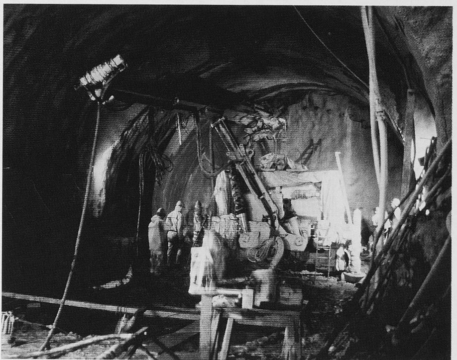
Bild 4. Horizontal-Jetgerät im Einsatz
