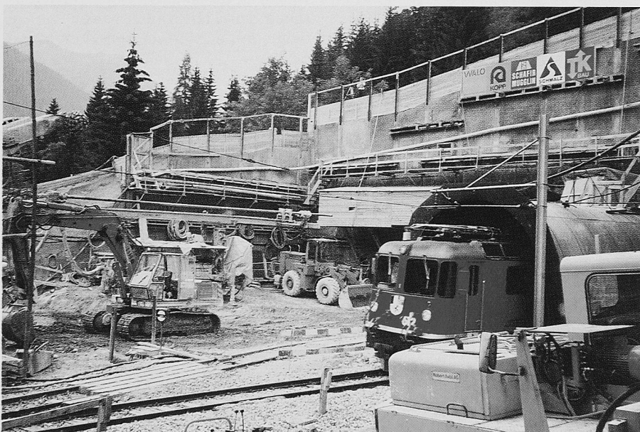
Bild 2. Blick in den Voreinschnitt des Zugwald-Tunnels in Klosters. Erkennbar sind die Schüttergerätschaft, der Schrämkopf, die Jettinginstallation und ein Zug der RhB im Schutzschild auf der Strecke nach Davos
