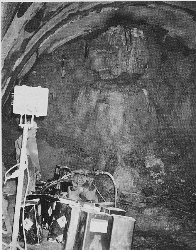
Bild 7. Sicherung eines Felsblockes im Scheitelbereich durch PU-Injektionen
