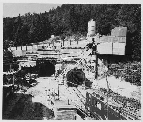
Bild 3. Blick in den Voreinschnitt des Zugwald-Tunnels in Klosters. Erkennbar sind die Portale des Zugwald- und des Klosterstunnels und die hochgelagerten Jettinginstallationen an der rechten Baugrubenwand
