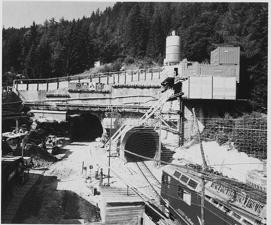
Bild 3. Blick in den Voreinschnitt des Zugwald-Tunnels in Klosters. Erkennbar sind die Portale des Zugwald- und des Klosterstunnels und die hochgelagerten Jetting-installationen an der rechten Baugrubenwand
