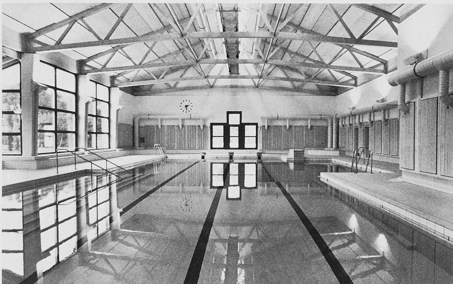
Bild 3. Hallenbad Rheinau, nach der Sanierung
