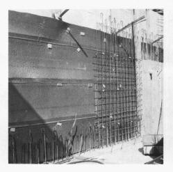
Filter- und Sickerschicht, keine Baugrubenverfüllung!
