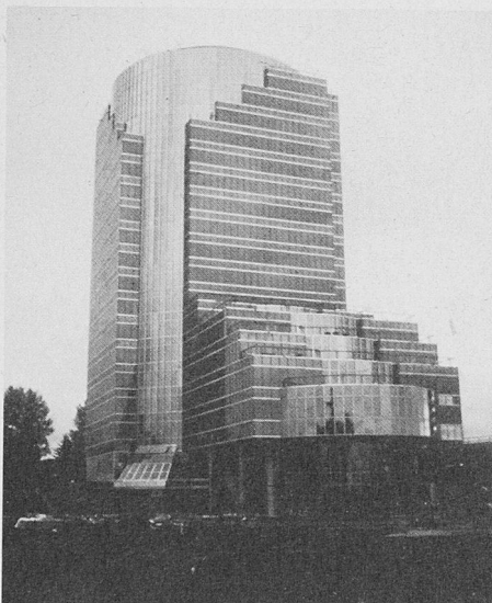
HIT-Verglasung beim Gateway Station Tower, Vancouver
