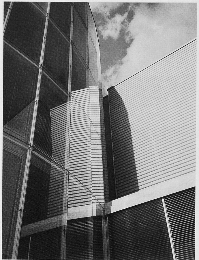
Detailansicht, Partie über dem Eingang
