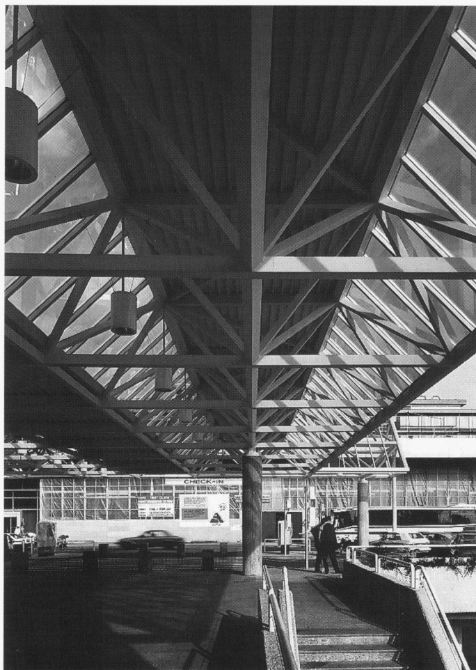
Fachwerke aus RHS-Profilen beim Bus-Terminal Flughafen Genf-Cointrin
