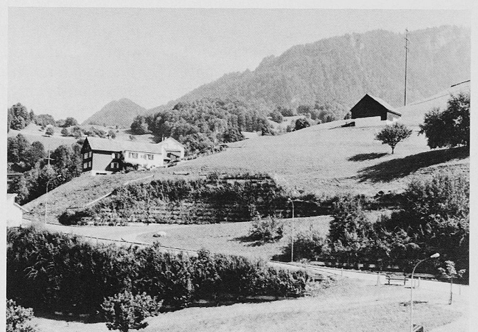
Bild 4. Ansicht der begrünten Wände nach drei Vegetationsperioden
