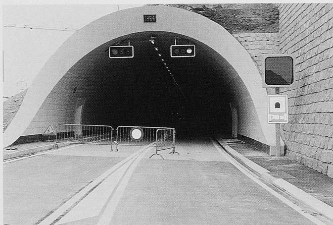
Bild 6. Regrouillon-Tunnel, Staatsstrasse Sion-Sierre (VS), aufgehellter Belag
