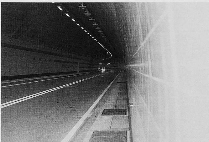
Bild 7. Aufgehellter Belag im Tunnelinnern, Regrouillon-Tunnel, Staatsstrasse Sion-Sierre (VS)
