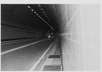
Bild 7. Aufgehellter Belag im Tunnelinnern, Regrouillon-Tunnel, Staatsstrasse Sion–Sierre (VS)
