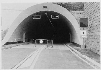
Bild 6. Regrouillon-Tunnel, Staatsstrasse Sion–Sierre (VS), aufgehellter Belag
