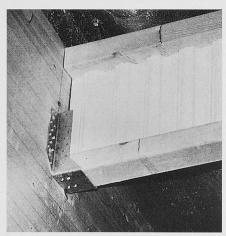
Bild 11: Auflagerung der Träger aus Bild 10 mit Balkenschuhen
