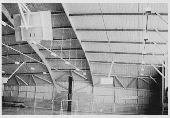
Bild 12: Sichtbar belassene Nail-Web-Träger als Dachpfetten und Fassadenstützen in einer Sporthalle
