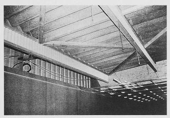
Bild 10. Nail-Web-Träger als Dachpfetten in einer Industriehalle
