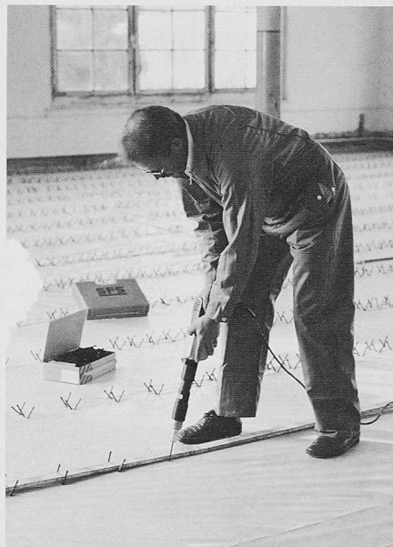
Bild 5. Setzgerät SFS CF40-VB
