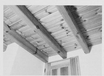
Bild 3. «Aufgehängter» Balken am Türsturz
