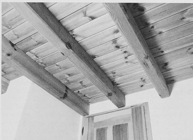
Bild 3. «Aufgehängter» Balken am Türsturz
