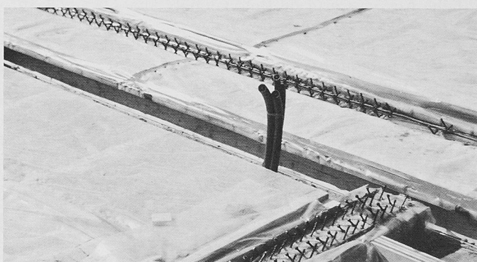
Bild 4. Neubau Schulhaus Eidmatt III in Wädenswil (Hurter &amp; Thoma, Wädenswil). Plastikfolien verhindern die Verschmutzung der Akustikdecke und der Brettschichtholzträger mit Zementmilch. (Foto: U. A. Meierhofer, EMPA, Dübendorf)
