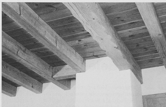
Bild 2. Unterzug für tragende KS-Wand im OG
