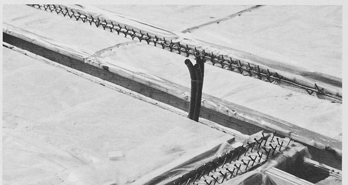
Bild 4. Neubau Schulhaus Eidmatt III in Wädenswil (Hurter &amp; Thoma, Wädenswil). Plastikfolien verhindern die Verschmutzung der Akustikdecke und der Brett-schichtholzträger mit Zementmilch. (Foto: U. A. Meierhofer, EMPA, Dübendorf)
