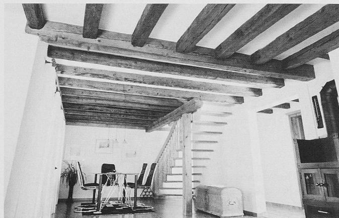
Bild 1. Unterzug für Deckenfeld und Leichtwände
