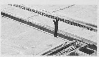
Bild 4. Neubau Schulhaus Eidmatt III in Wädenswil (Hurter & Thoma, Wädenswil). Plastikfolien verhindern die Verschmutzung der Akustikdecke und der Brettschichtholzträger mit Zementmilch. (Foto: U. A. Meierhofer, EMPA, Dübendorf)
