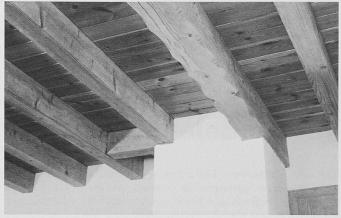
Bild 2. Unterzug für tragende KS-Wand im OG
