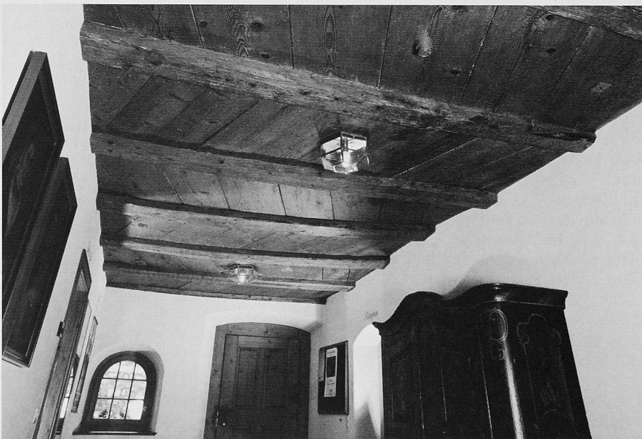
Bild 6. Gasthof Löwen. HBV-verstärkte Balkendecke mit Schrägboden aus dem 17. Jahrhundert
