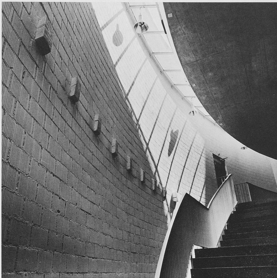
Der grosszügig über alle Stockwerke durchgezogene, leicht gewölbte Schild hält und prägt die neue Treppenanlage
