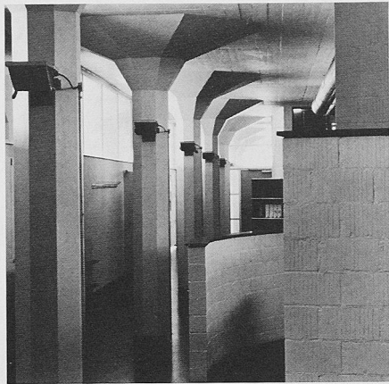
Säulen erzählen die Geschichte des Hauses: Gusseisenstütze im UG Haupttrakt, Pilzsäulen im 1. OG Haupttrakt, Pilzsäule Lerchenwegtrakt 2. OG
