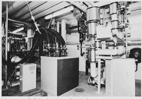
Wärmepumpe für Erdsondenanlage auf dem Prüfstand
