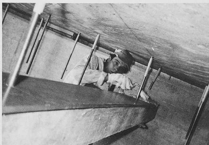
Bild 8. Aufbringen des Klebers auf die Lamellen
