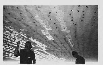
Bild 5. Abdichten der Risse für die Injektion
