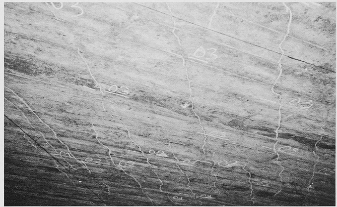
Bild 3. Risse an der Plattenunterseite
