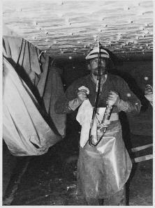
Bild 6. Injektion der Risse in den Nachtstunden
