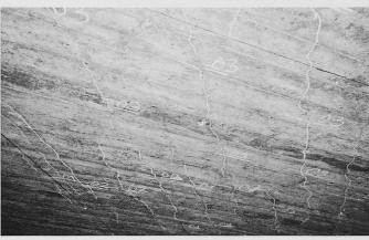
Bild 3. Risse an der Plattenuntersicht
