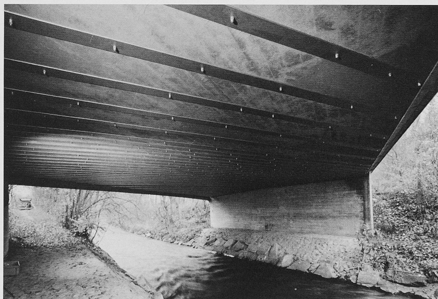
Bild 9. Fertig verstärkte Brücke
