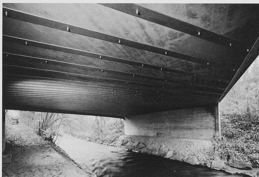
Bild 9. Fertig verstärkte Brücke
