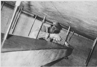
Bild 8. Aufbringen des Klebers auf die Lamellen
