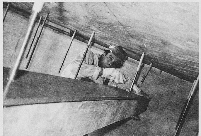
Bild 8. Aufbringen des Klebers auf die Lamellen
