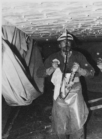
Bild 6. Injektion der Risse in den Nachtstunden
