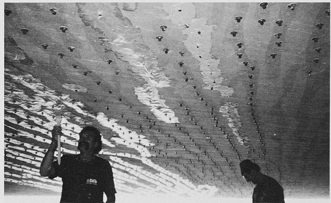
Bild 5. Abdichten der Risse für die Injektion
