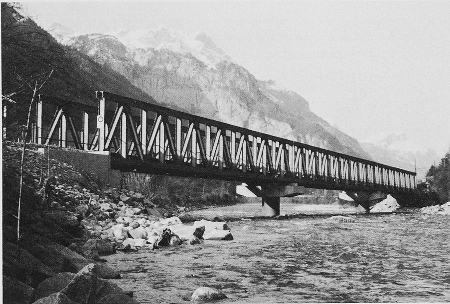
Bild 5. Brücke Erstfeld Modell 1936. Blick flussabwärts
