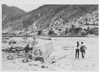
Bild 1. Uferschutzmauer. Das raschere Wegfliessen in der Nähe der Mauer führt zu einem seitwärts gerichteten Zufliessen aus der Mitte des Flussbettes (Bild: E. Decormis, Sucre)
