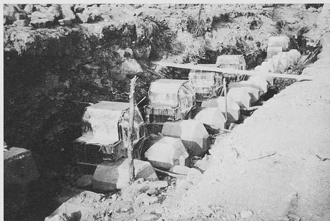
Bild 11. Metallschalungen und fertige Blöcke
