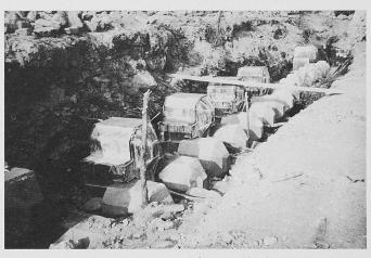
Bild 11. Metallschalungen und fertige Blöcke
