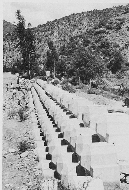
Bild 8/9. Die Uferschutzmauer nach Erreichen der vollen Höhe im Februar 1989 (Bilder: E. Decormis, Sucre)
