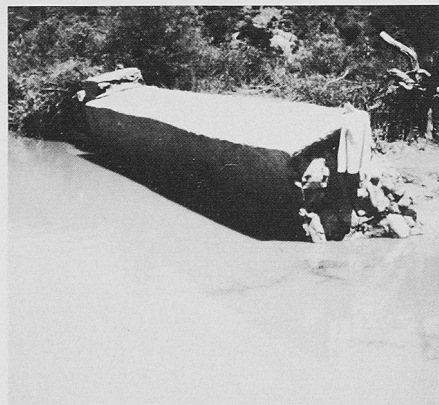
Bild 5. Mehrere Meter unterhalb des Flussgrundes fundierte Mauern werden innert weniger Jahre unterspült
