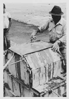
Bild 12. Ein Block ist fertig gegossen (Bild: E. Decormis, Sucre)
