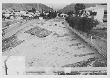
Bild 2. Bei beidseitig vorhandenen Mauern teilt sich der Fluss aufgrund der Strömungsverhältnisse. Es können sich in der Mitte Inseln bilden
