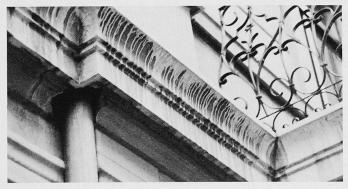
Bild 7. Kalkaussinterungen, unabgedeckte Gesimse
