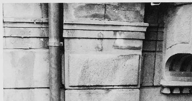
Bild 5. Schäden durch defekte Dachwasserrohre
