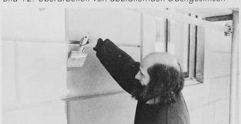
Bild 14. Festigen von Platten mit Kieselsäureester
