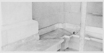
Bild 10. Gesimse-Schutz durch Blechabdeckung
