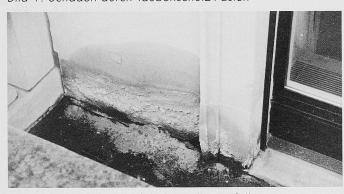
Bild 3. Schäden durch falsche Balkongefälle
