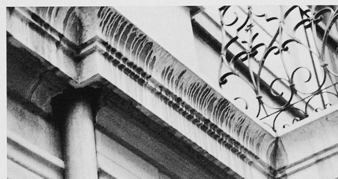
Bild 7. Kalkaussinterungen, unabgedeckte Gesimse
