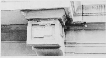
Bild 4. Zerstörte Profilierung, falscher Wasserabfluss
