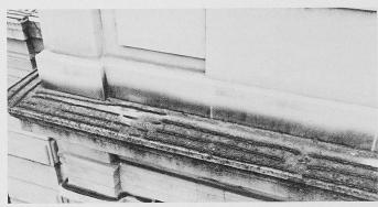
Bild 2. Schäden durch unabgedeckte Gesimse
