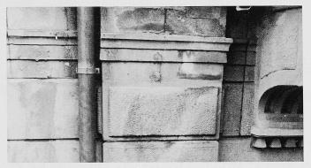
Bild 5. Schäden durch defekte Dachwasserrohre
