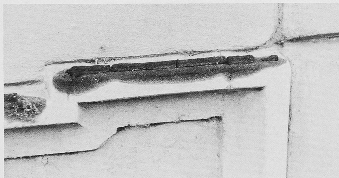
Bild 1. Schäden durch Taubenschutz-Pasten
