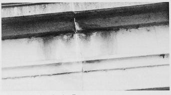
Bild 8. Schäden durch offene Fugen
