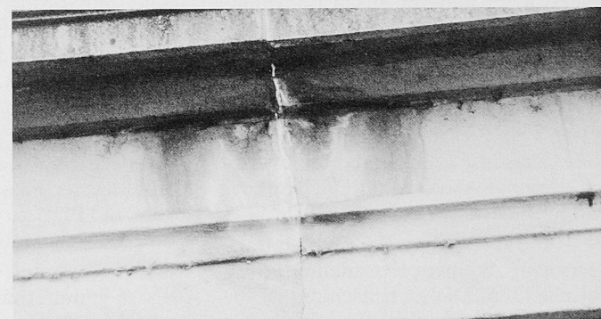
Bild 8. Schäden durch offene Fugen
