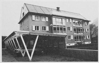
Das Solarhaus in Sevelen ist das erste grössere, weitgehend energieautonome Mehrfamilienhaus in der Schweiz. Obwohl mit 110 m² Sonnenkollektoren, einem 25 000-Liter-Wasserspeicher und mit 200 mm dicker Wärmedämmung ausgestattet, sind die Baukosten nicht höher als bei konventioneller Bauweise
