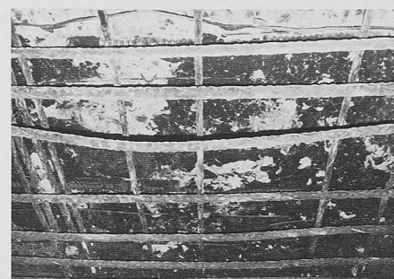
Bild 8. Unterseite Fahrbahnplatte Brandbereich
