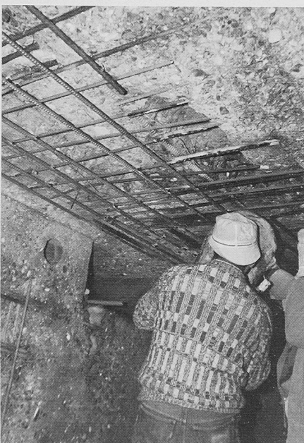
Bild 14. Sanierung Fahrbahnplatte
