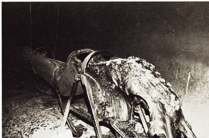
Bild 5. Brückenentwässerung Hauptleitung verbrannt und geschmolzen
