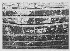
Bild 8. Unterseite Fahrbahnplatte Brandbereich
