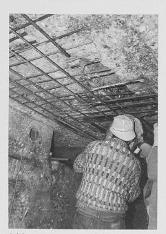
Bild 14. Sanierung Fahrbahnplatte
