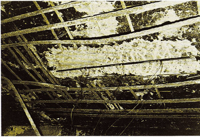
Bild 11. Prüfung Quervorspannung an Ort
