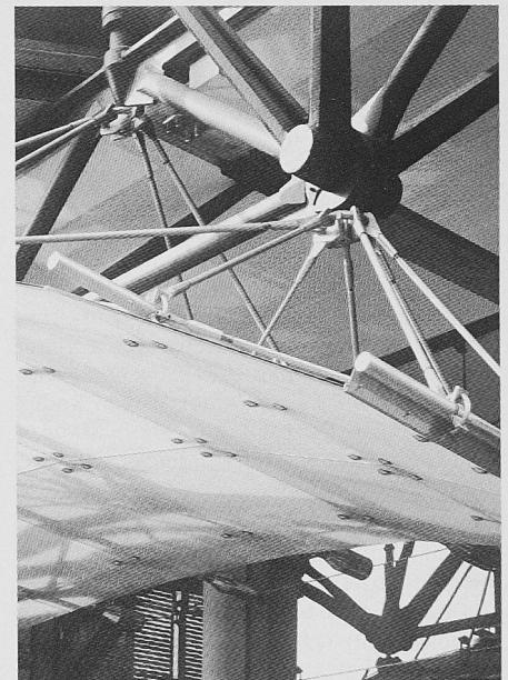
Bracken House, London, 1987–1992. Umbau der ehemaligen Financial Times, Detailausbildung beim Vordach über dem Haupteingang
