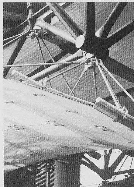
Bracken House, London, 1987–1992. Umbau der ehemaligen Financial Times, Detailausbildung beim Vordach über dem Haupteingang
