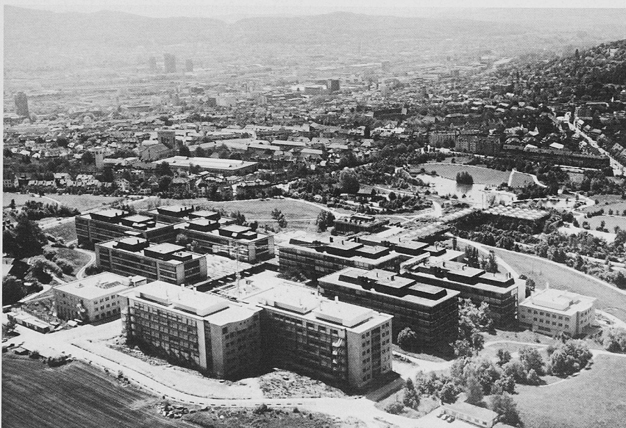
Die Flugaufnahme zeigt die vier hellen Neukomplexe der Universität Zürich-Irchel, drei Institutsgebäude links im Vordergrund und eines ganz am rechten Bildrand (Bild: Comet)
